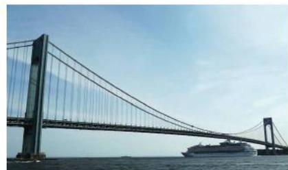
Les tours des ponts très longs, comme le Verrazano à New York, ne sont pas parallèles à cause de la variation de l'orientation du champ gravitationnel due à la courbure de la Terre: le centre de gravité de chaque tour doit se trouver à la verticale par rapport à sa base. Il y a donc entre elles un angle d'environ  $0,1^\circ$ .
