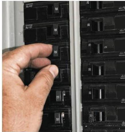
La majorité des coupe-circuits domestiques comportent un bilame qui en se déformant ouvre le circuit électrique et protège les fils d'alimentation d'une éventuelle surchauffe.
